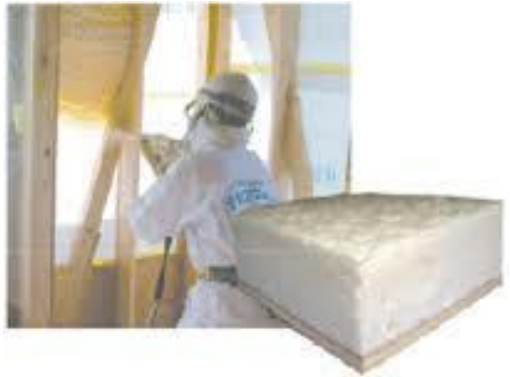
吹付ウレタンによる均一施工
